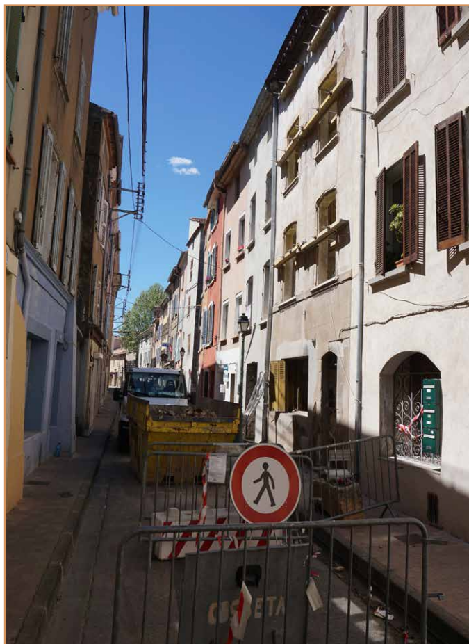
Travaux de la maison du 53 grande rue
